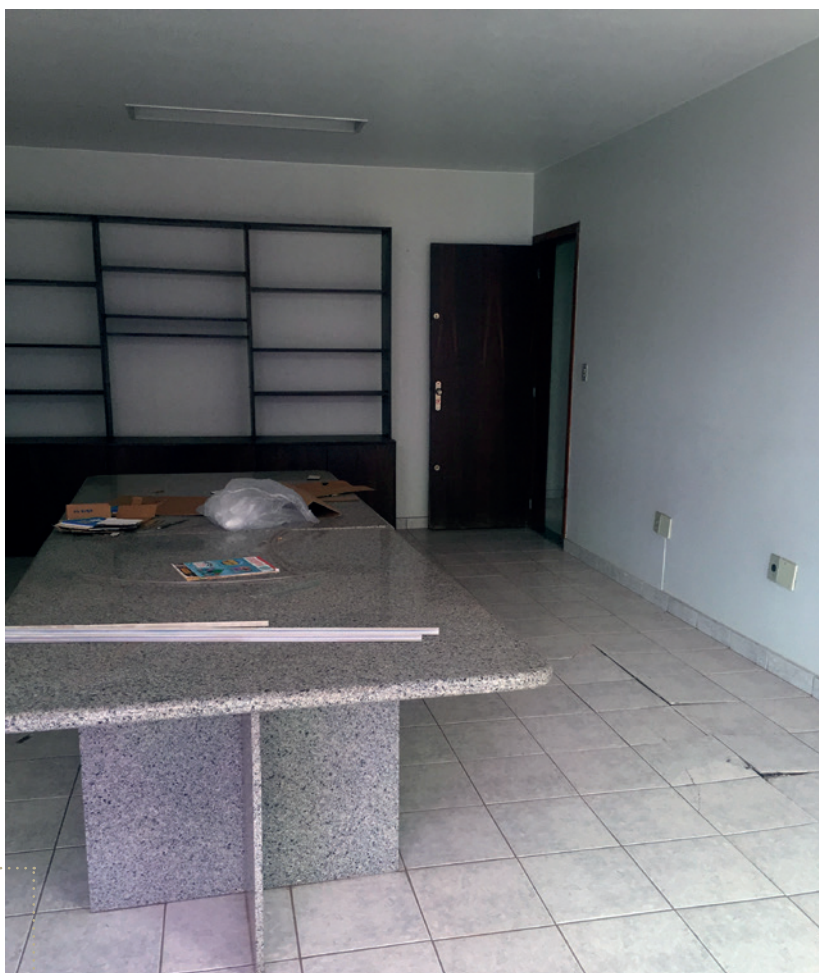
Sala de reuniões da antiga sede, com piso deteriorado
